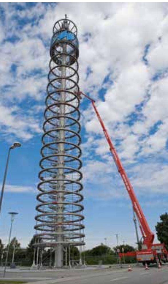
Antennen von Hochfrequenzanlagen befinden sich meist auf Masten und Türmen, manchmal auch „versteckt“ in Dächern von hohen Gebäuden. Die Besetzung einer Hubarbeitsbühne kann leicht, ohne sich dieser Gefahr bewusst zu sein, in diese energiereichen Hochfrequenzfelder geraten – sehr hohe Dosen von HF-Strahlung können sogar tödlich sein!
