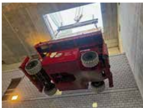
Schwebebühne: Mit dieser Holland-Lift HL-220 H25 aus dem Sky-Access-Mietpark wurden auf einer Großbaustelle in Bern unter der Decke in rund 14 Metern Höhe schwere Komponenten für die Lüftung und Klimatisierung montiert. Weil der direkte Zugang durch den Baufortschritt versperrt war, musste die rund 13 Tonnen schwere Schere per Kran durch eine nur 3 x 5,5 Meter große Deckenaussparung eingehoben werden, die kaum größer war als die Maschine selbst – eine enorme Herausforderung für Kranführer und Einweiser.
