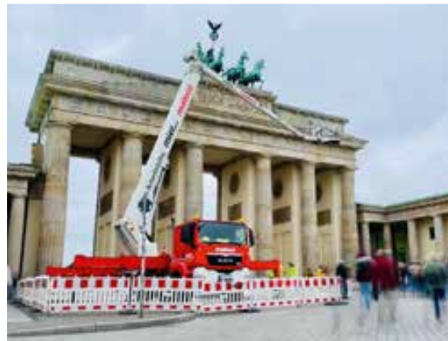
Wahrzeichen digital: Das gesamte Brandenburger Tor wurde per Laserscan abgetastet, um digitale Daten für eine virtuelle Konservierung, wie auch zur Erstellung eines 3D-Modells zu gewinnen. Für die verschiedenen Abschnitte der ungewöhnlichen Aufgabe waren von Mateco neben dieser 54-Meter-LKW-Arbeitsbühne LT 540 K D 4x4 auch die Spezial-Arbeitsbühne XTG 170 K D/E KE sowie einige Scheren im Einsatz. (Bild: Mateco)
